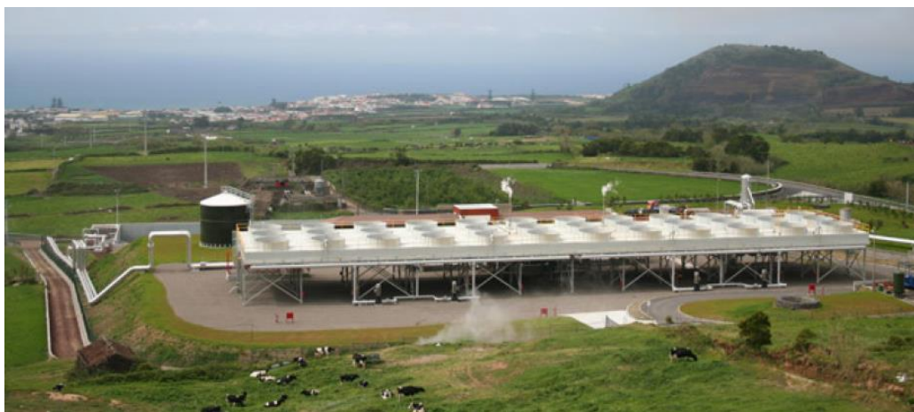
Central Geotérmica de Pico Vermelho 10 MW (2007)
