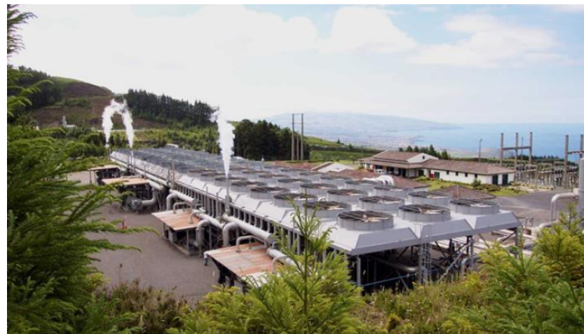
Central Geotérmica da Ribeira Grande 5 MW (1994) + 8 MW (1998)
